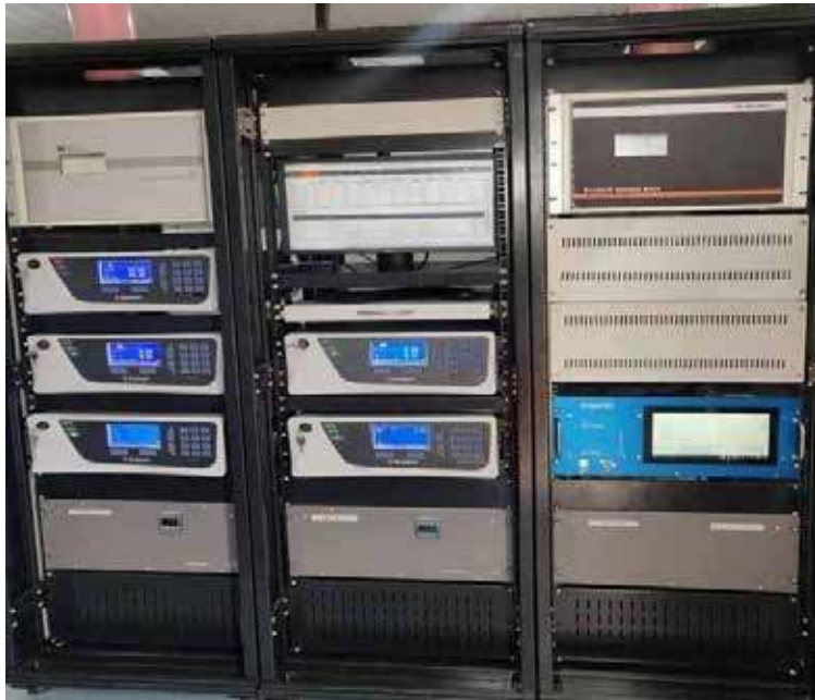
चित्र 1: सीएएक्यूएमएस में स्थापित विभिन्न वायु प्रदूषक एनालाइजर विहंगम दृष्टि में Figure 1: Overview of various air pollutants analysers installed at the CAAQMS
