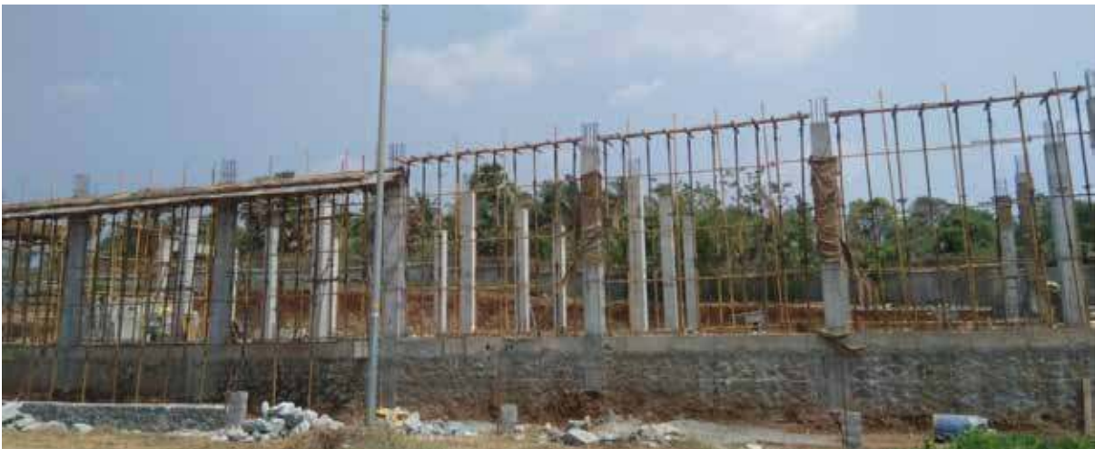
ठोस अपशिष्ट प्रबंधन भवन
